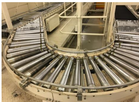
ローラーコンベアライン
