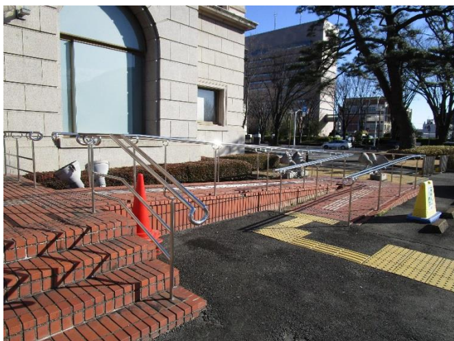
○南西側入口（スロープ幅 116cm、自動ドア幅 120cm）
