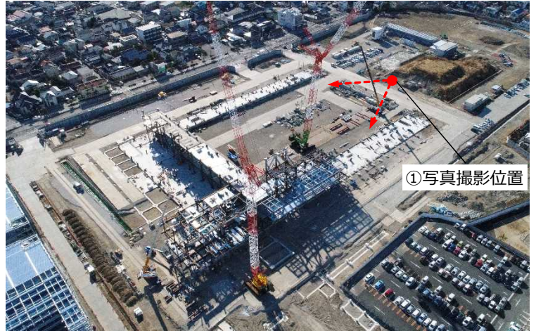
△ ②敷地上空からの工事の様子
