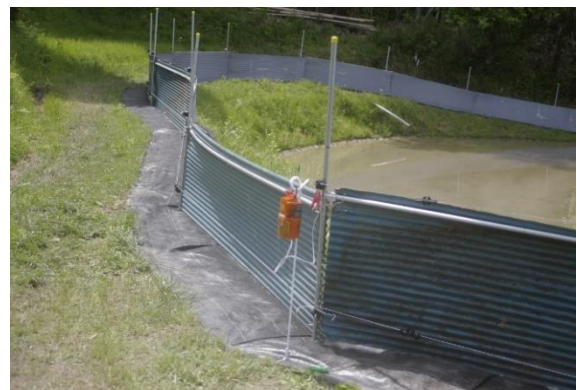
B:トタン板と電線の複合柵
