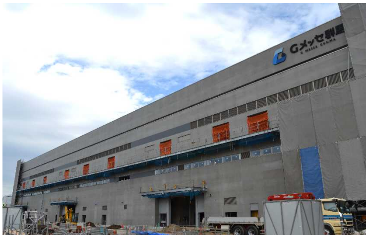
△ 展示施設南面の工事の様子
