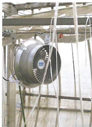
写真2 循環扇の設置状況
