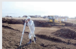
ほ場整備で、測量機器により整地完了後の高さを確認中
