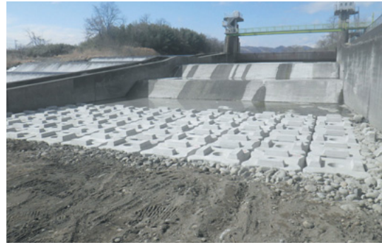
長寿命化が図られた頭首工（高崎市：長野堰）
