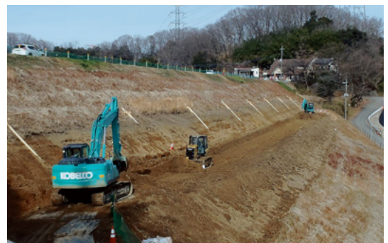
堤体の対策工事状況
