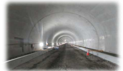
写真は二次覆工完了・排水溝設置の段階です。
