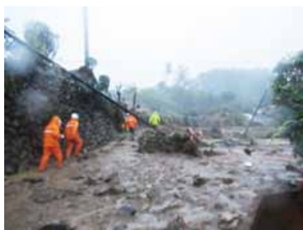
令和元年 台風被害（富岡市）
