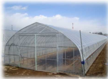
パイプハウス
