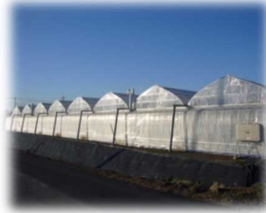
鉄骨パイプハウス
