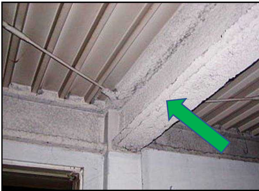
①鉄骨の柱や梁への吹付
