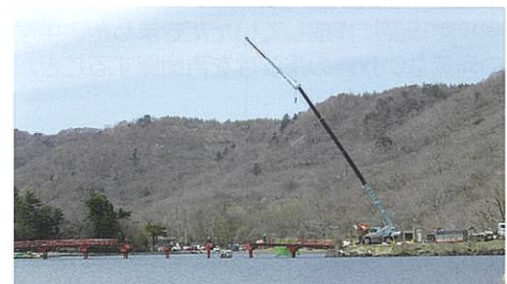
写真4：撤去中の啄木鳥橋
