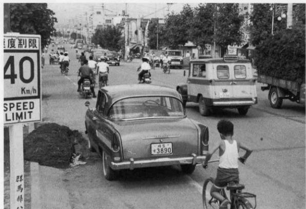
左上と左下は国道17号線の写真です。道路は舗装されていますが、縦横に線が見えます。これは、コンクリートを使って舗装した道路です。長い板を使って四方を囲んだ中にコンクリートを流し入れ、コンクリートが固まってから板をはずすという作業を繰り返して道路を舗装しました。道路にはバスやオート三輪が多く、自家用車は現在ほど普及していませんでした。
