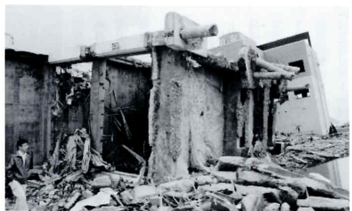
土台ごと津波により横倒しになったビル(女川町)
