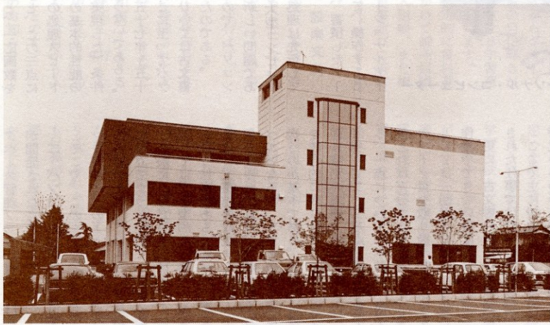
文書館全景 鉄筋コンクリート造、地上3階、地下2階 延床面積3,306㎡（うち書庫面積1,390㎡）
