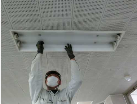
①蛍光管をはずす。
