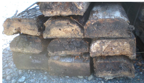
図-2 回収した木道敷板
