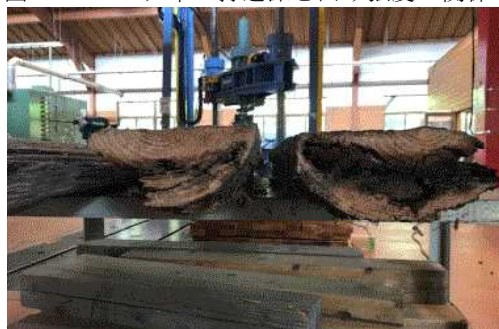
図-7 中心部が空洞化した敷板
