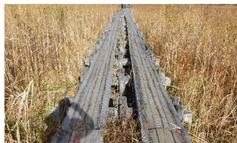
図1 試験体の木道踏板
