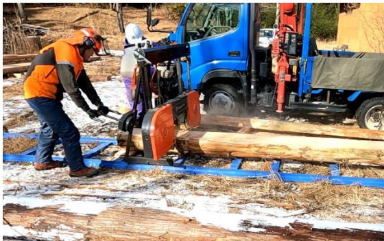
図-3 スギ丸太（8m）現地製材の様子
