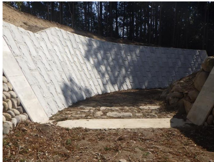
もたれ式擁壁工【完成】
