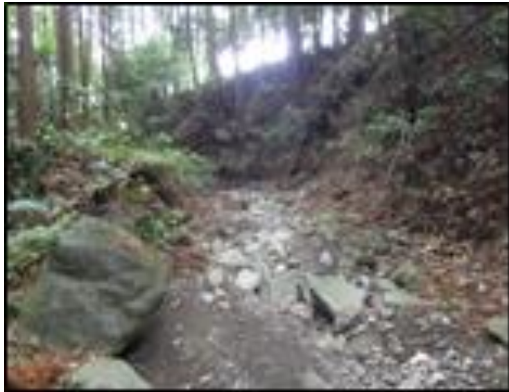
整備前の河川状況
