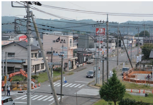
用地買収が進む西毛広域幹線道路
