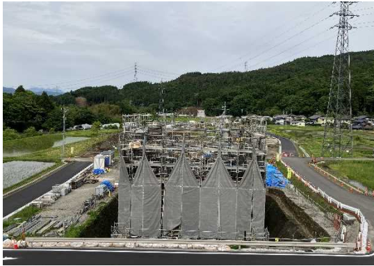
工事中の(仮称)厚田IC橋の橋台
