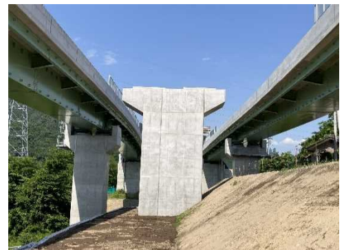
完成した(仮称)箱島IC橋の橋脚
