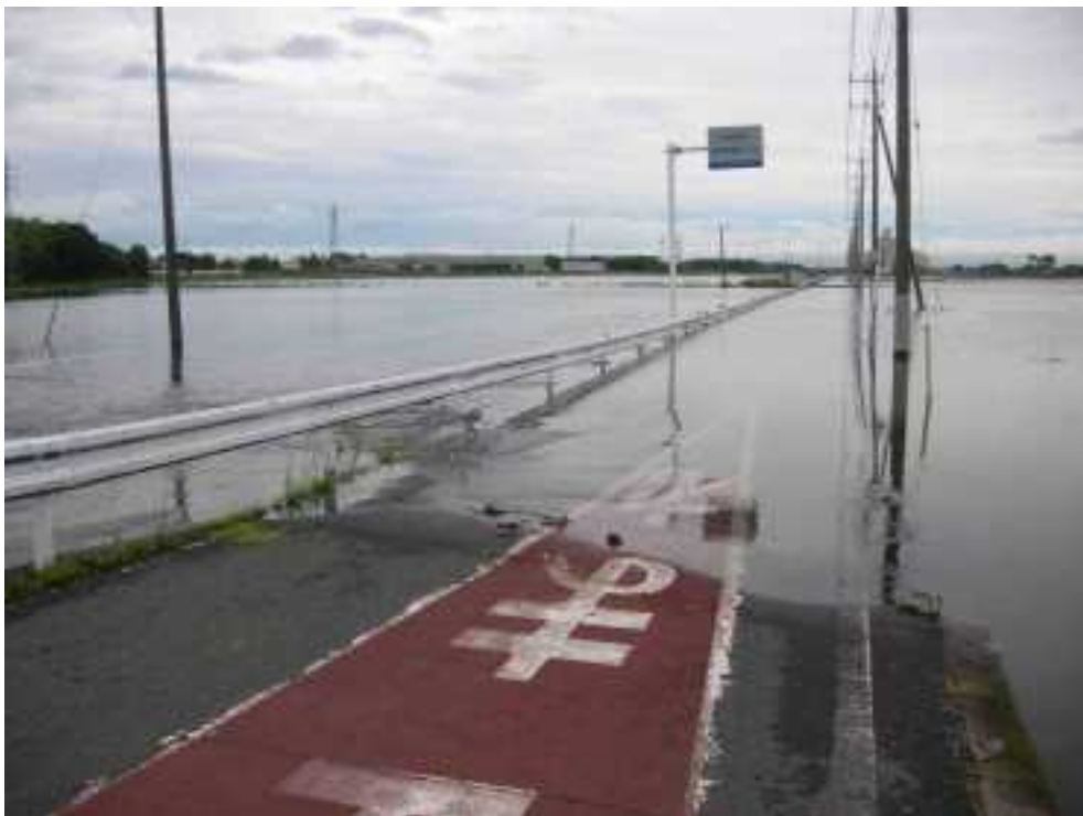
新堀川・町道冠水状況（邑楽町）
