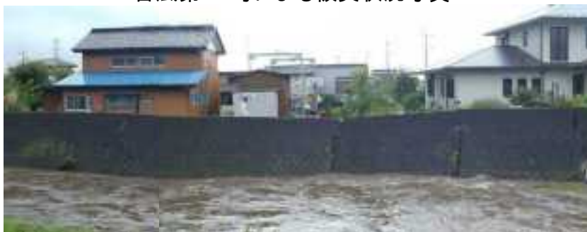
台風第12号による被災状況写真
