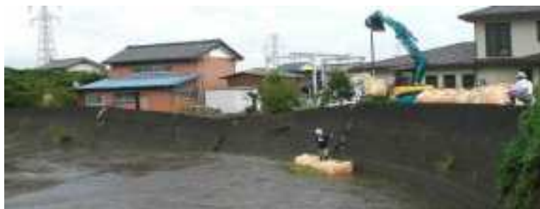
応急仮工事状況写真
