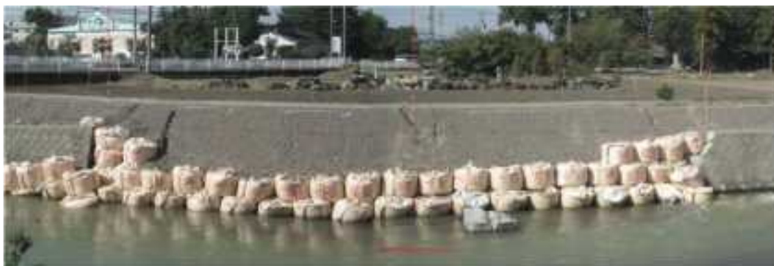
応急仮工事完了写真
