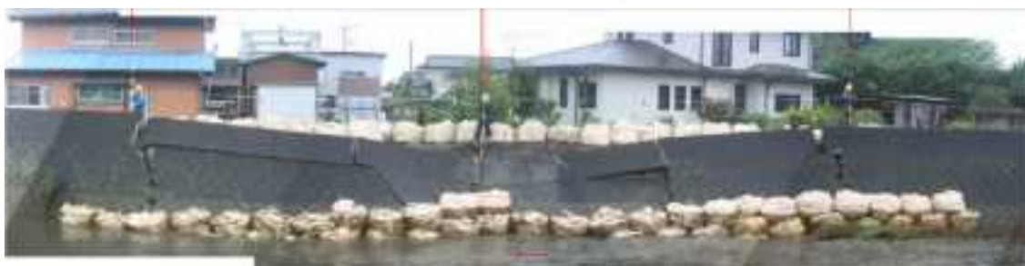
応急仮工事完了写真
