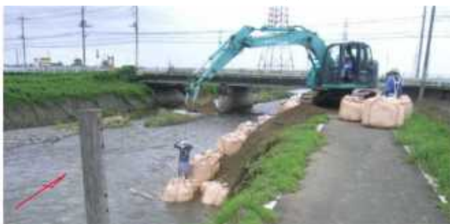
応急仮工事状況写真
