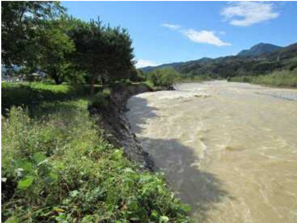
利根川 被災状況 (沼田市)
