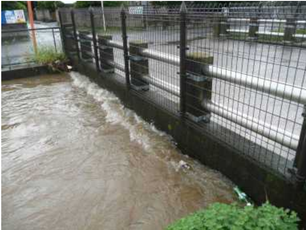
菰川出水状況（伊勢崎市）
