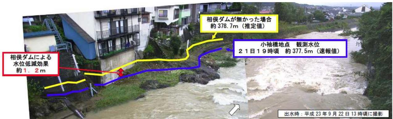
相俣ダムの調節による水位低減効果 (9月21日19時頃の相俣橋付近の水位状況)
