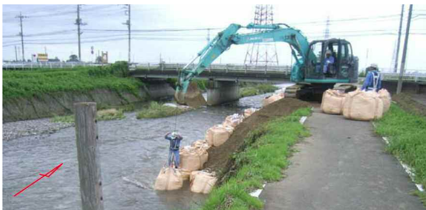
応急仮工事状況写真
