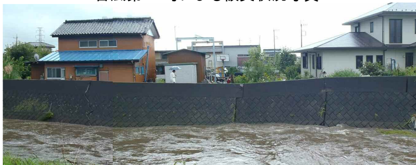
台風第12号による被災状況写真
