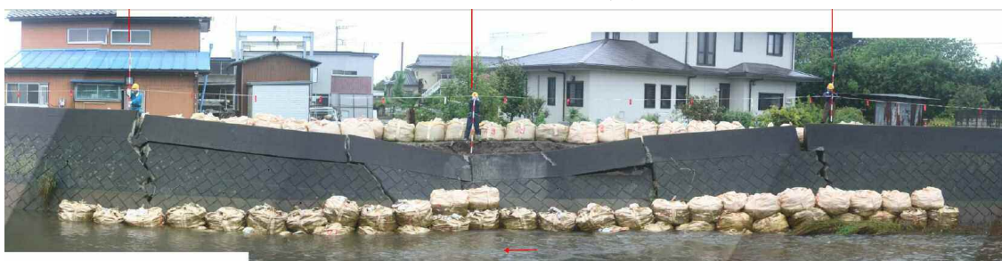
応急仮工事完了写真
