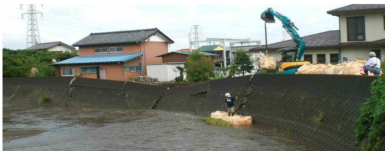
応急仮工事状況写真
