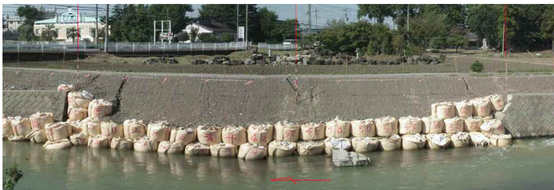
応急仮工事完了写真
