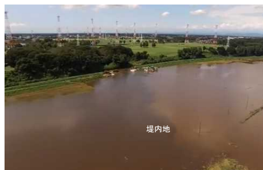
出典：平成27年9月 国土地理院 西仁連川堤防決壊＝茨城県結城市
