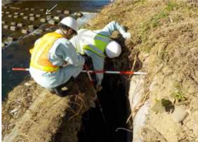
蛇川 被災事象:河床洗掘による裏込材流出 (太田市)
