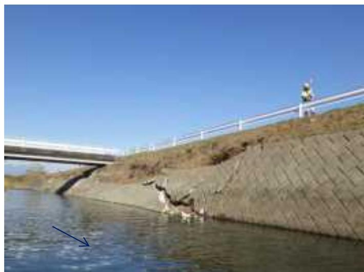
早川 被災事象: 河床洗掘による護岸挫屈崩壊 (伊勢崎)
