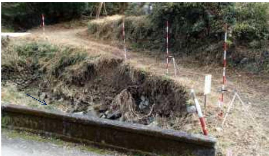
名久木川 被災事象:河床洗掘による石積護岸崩壊 (桐生市)
