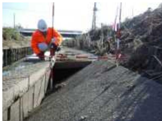
新堀川 被災事象:河床洗掘による裏込材流出 (館林市)
