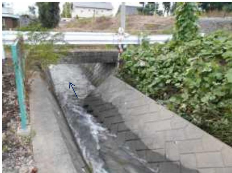
大川 被災事象:河床洗掘による護岸側倒 (太田市)
