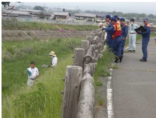
重要水防箇所 合同点検
