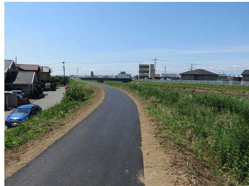
堤防天端舗装（赤城白川）
