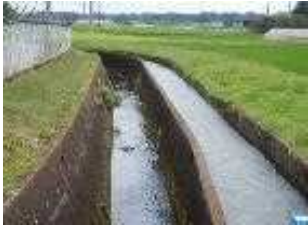
2 神流川用水地区【施設状況】
