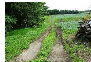
1 仙之入地区【工事着手前】
