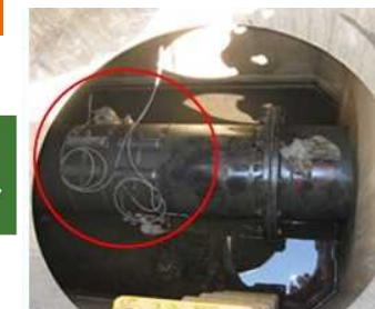
2 利根加用水2期地区 【工事着手前】
