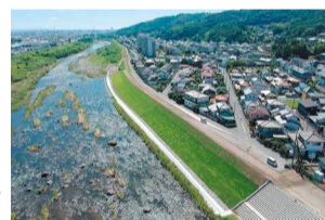
河川改修(碓氷川)
