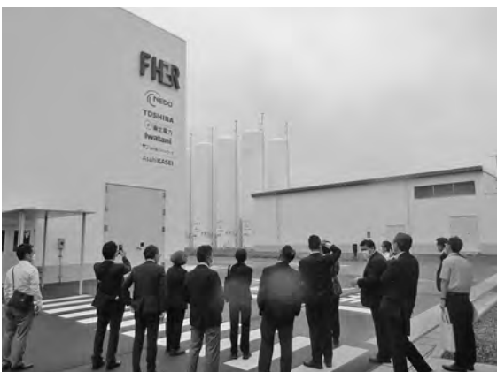
FH2Rの水電解装置施設や水素貯蔵・供給設備施設を視察する様子
