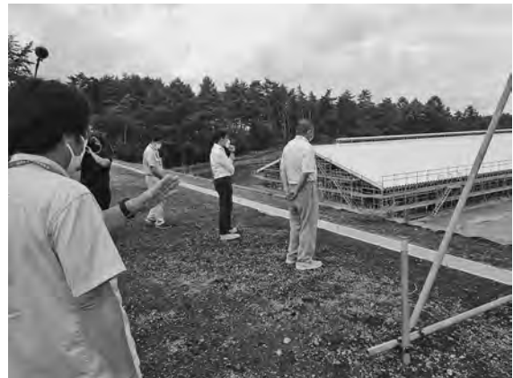
建築中の新牛舎を視察する様子
