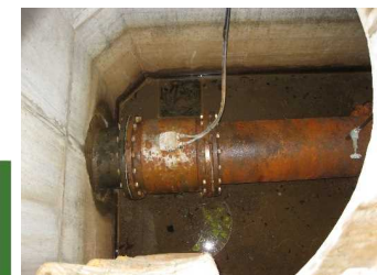
2 利根加用水2期地区【工事着手前】
