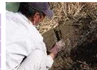
4 太田市市前地区【水路の目地補修】
