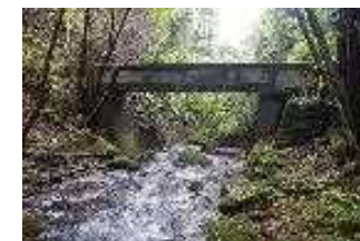
2 美野原3期地区【工事着手前】
