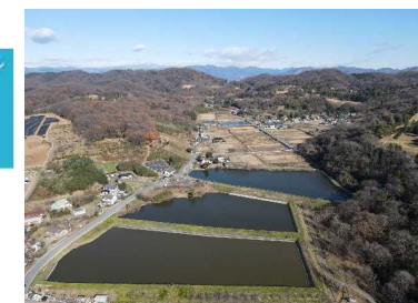
3 西長岡ため沼【地震対策工事】
