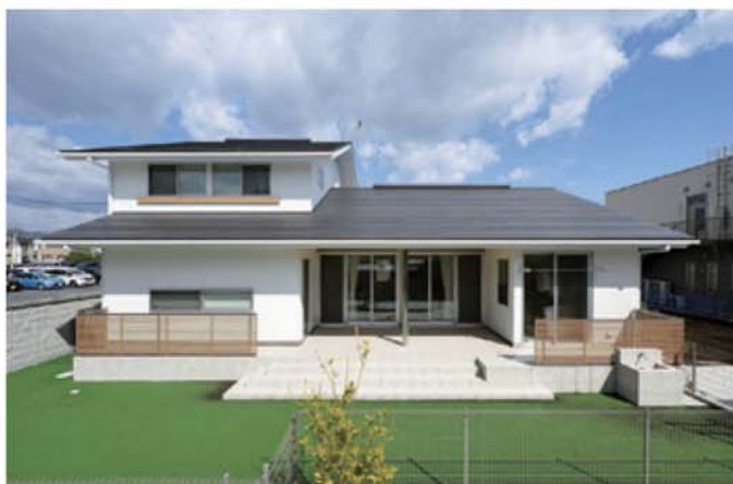
木造2階 | T house (ティーハウス)
