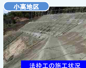
法砕工の施工状況
