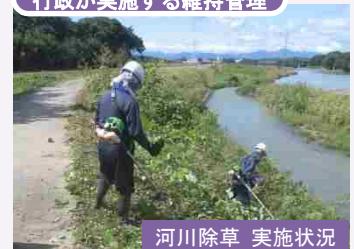
河川除草 実施状況
