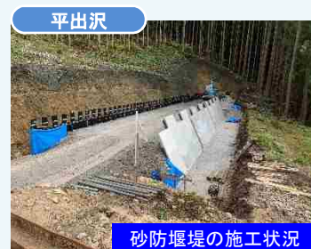
砂防堰堤の施工状況
