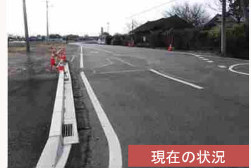
県道三夜沢国道停車場線 深津工区
