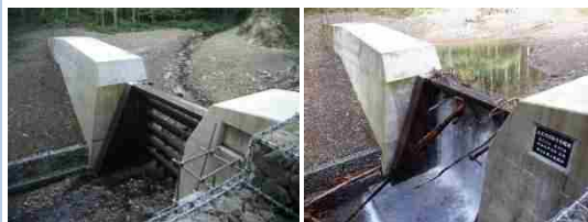
堰堤完成後の捕捉状況
