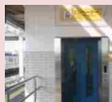
エレベーター設置
