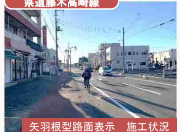
矢羽根型路面表示 施工状況
