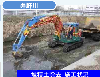
堆積土除去 施工状況
