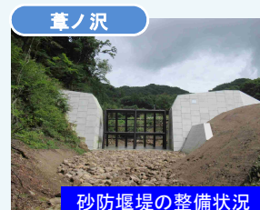
砂防堰堤の整備状況
