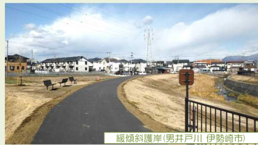
緩傾斜護岸(男井戸川 伊勢崎市)
