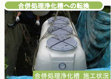
合併処理浄化槽への転換
