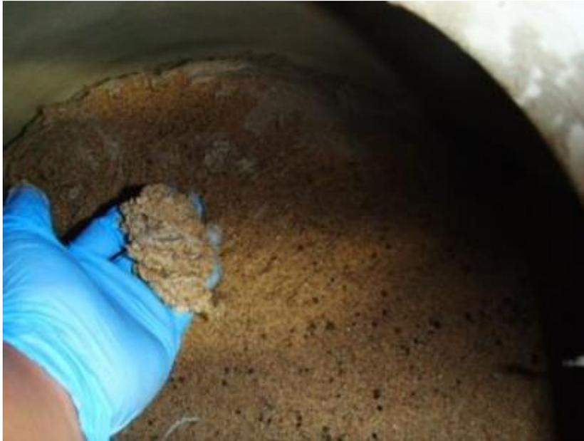
過酸化水素消毒後にレジオネラ属菌が検出された。脂肪分が残留しているろ過砂
