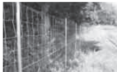
侵入防止柵の設置
