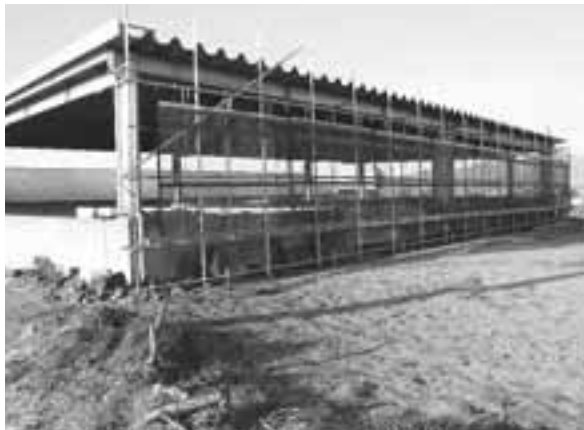
運転試験中のネットを用いた脱臭装置
