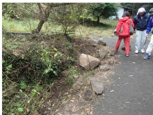
C: 道路法面の掘り起こし
