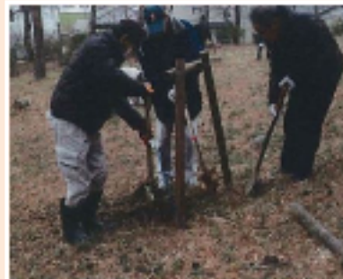
植栽作業の状況
