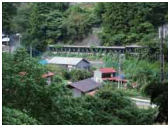
集落を守る落石防護壁
