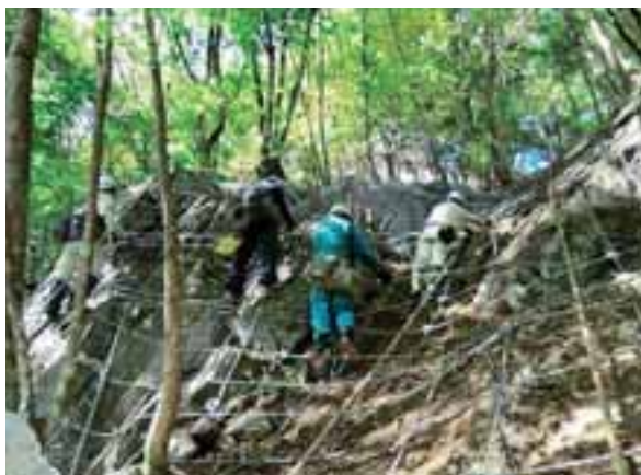
山地災害危険地区の事前防災（落石防止対策）
