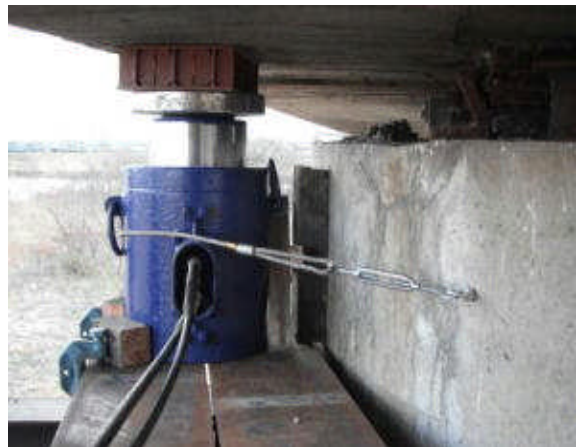
油圧ジャッキによる上部工の持ち上げ（左写真における赤丸部の拡大）=3月
