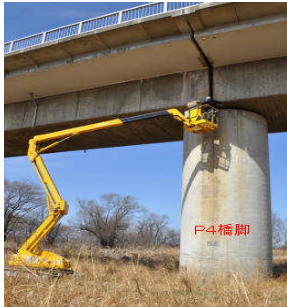
高所作業車による被災箇所の詳細調査=3/12
