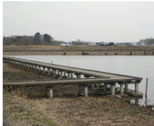
復旧状況 中野沼公園（邑楽町）＝平成24年3月
