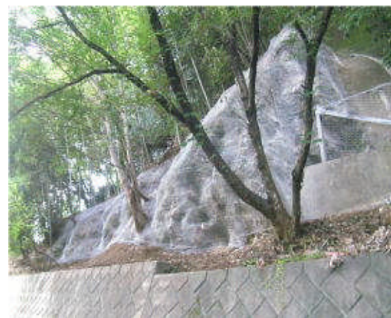
固定工による復旧後＝10月、H23 県単治山事業
