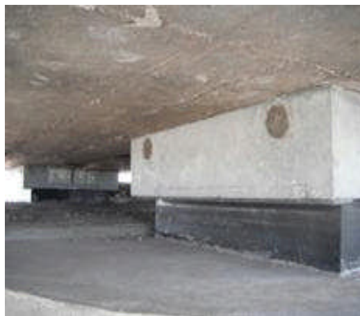
ゴム支承への交換が完了した支承部=4/20
