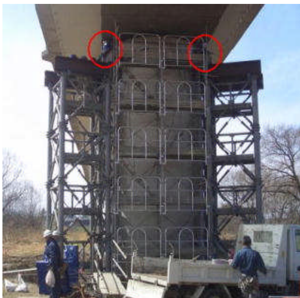
油圧ジャッキを据え付ける支保工の組み立て=3月
