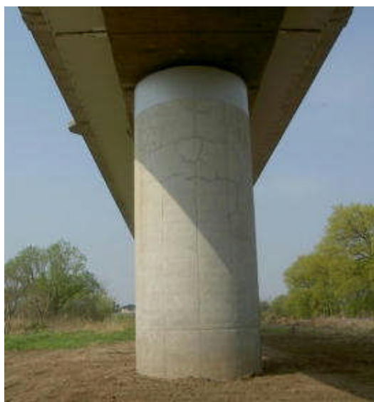
復旧工事が完了したP4橋脚=4/20
