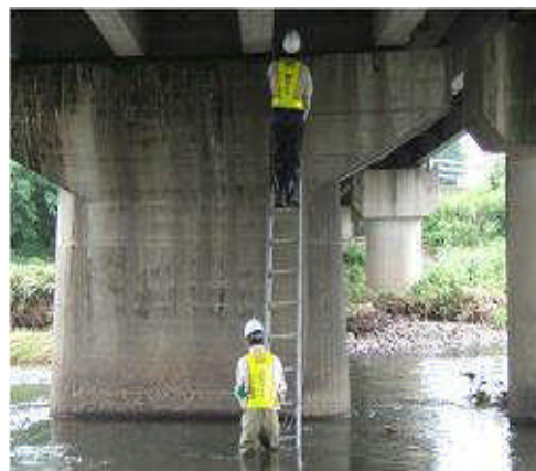
緊急橋梁点検による支承部の点検
