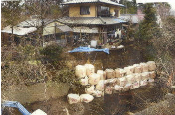
大型土のうによる応急復旧工事 （鳥井沢：桐生市黒保根町下田沢地先）
