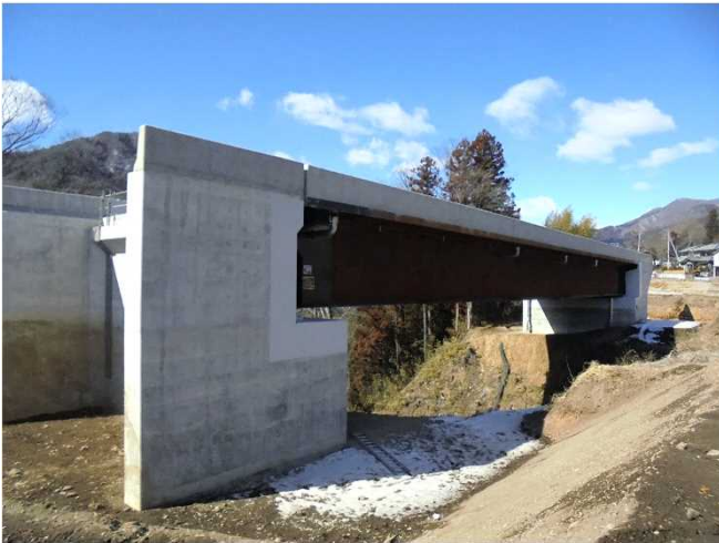
上部工事が完成した上信石上橋
