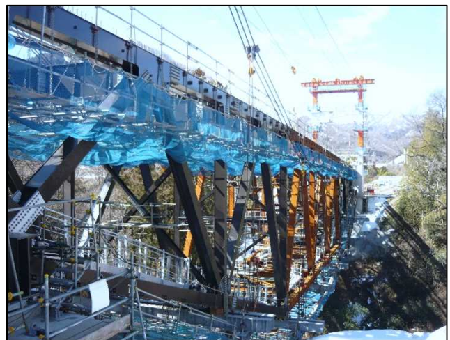
桁架設完了状況
