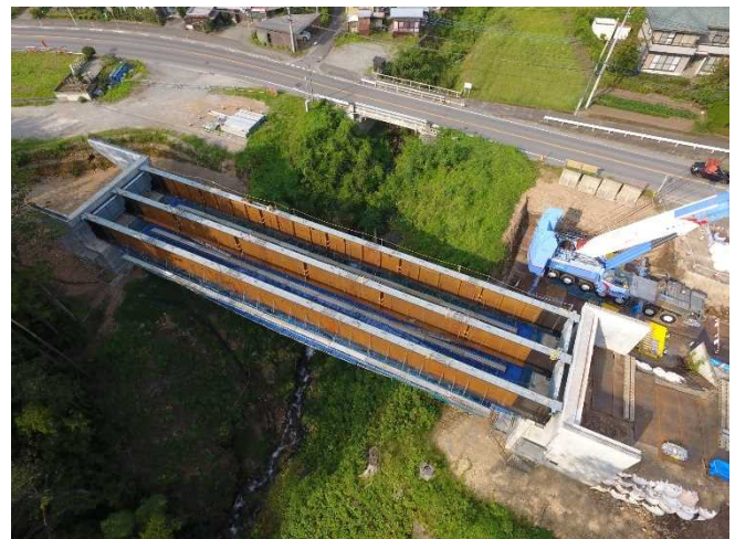
写真②：桁架設完了
