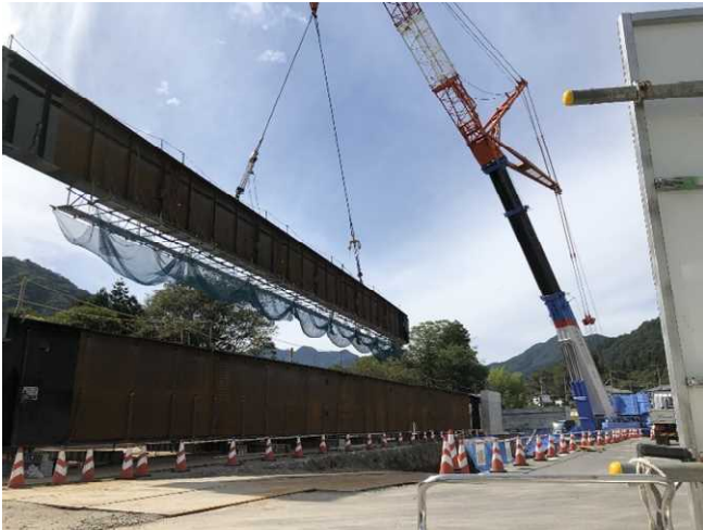
写真①：桁架設状況
