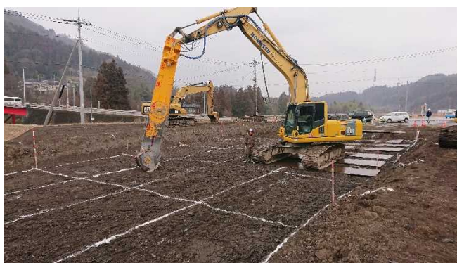
写真：地盤改良工事の例 高い盛土を支えるためにあらかじめ地盤を固める工事です。
