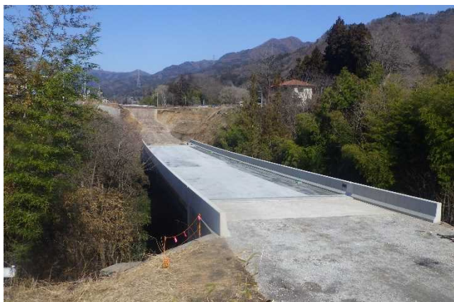
完成する上信万木沢橋
