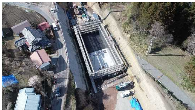
万木沢2号ボックス 施工中の様子
