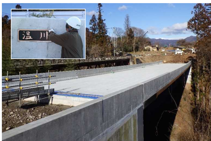
完成した上信温川橋
