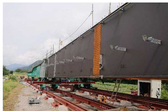
架設工事の様子
