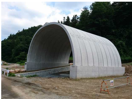
根古屋地区 アーチカルバート R1.6.25撮影
