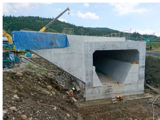
厚田地区 ボックスカルバート R1.6.25撮影
